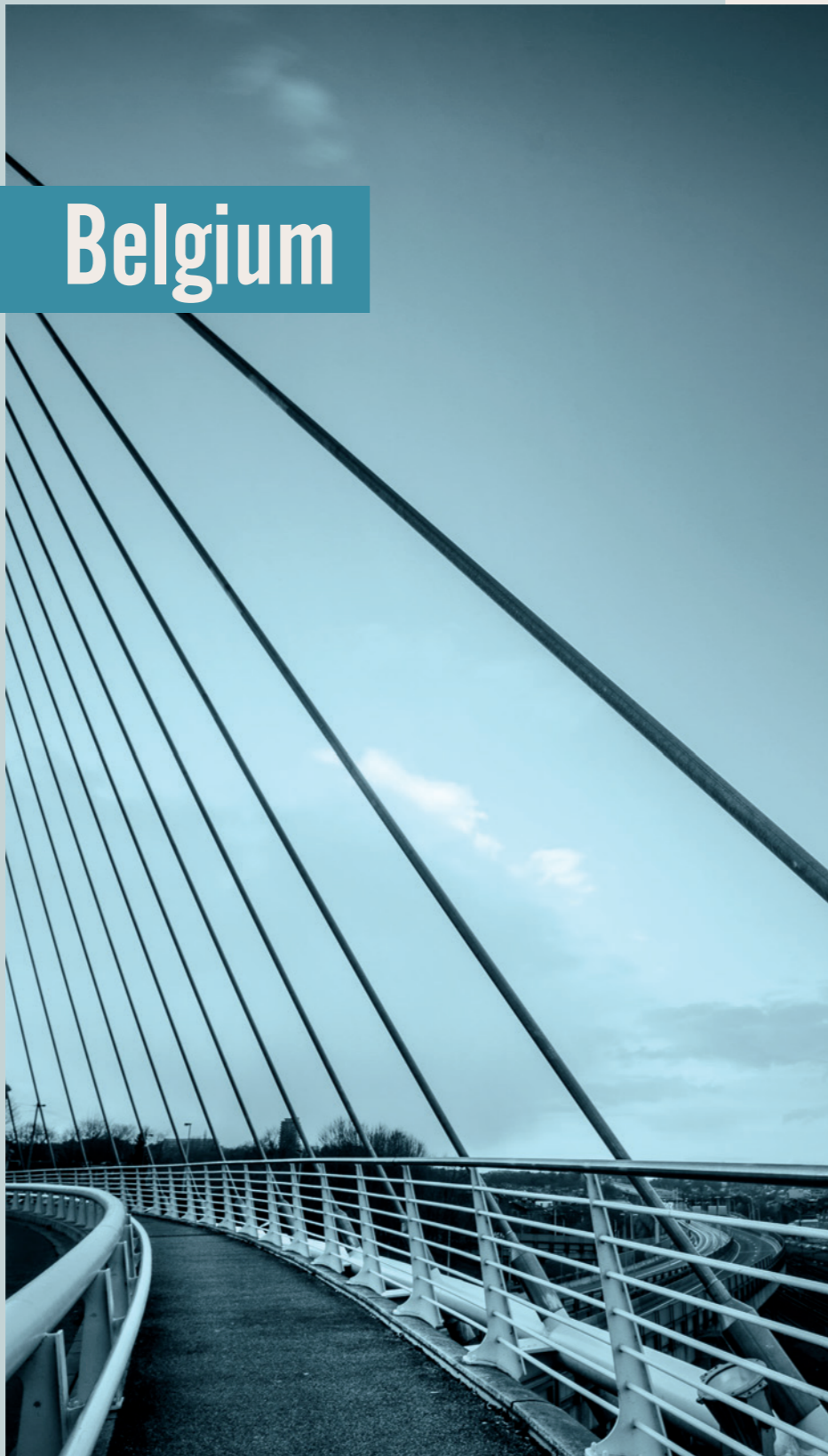
Liège Guillemins bridge, Liège
